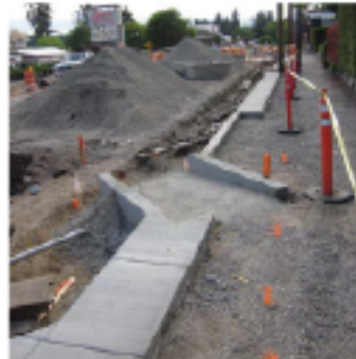
Mod. Gravel Layer
